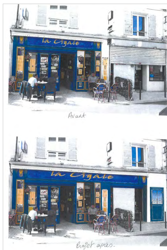
Photos du projet de regroupement du local commercial et de la création de l'accès extérieur. Crédit Urbam conseil
