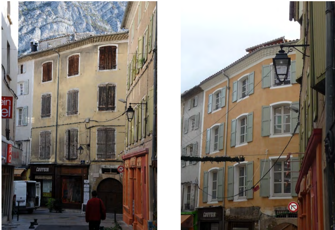
Figure 1 : Vue de l'îlot d'Ornano (avant-après). Source DDT
