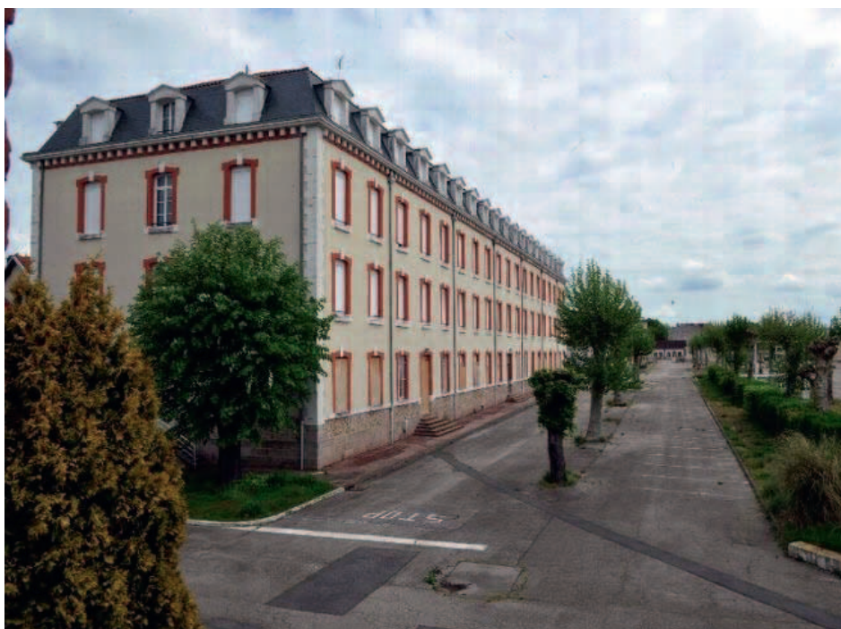
La caserne Marceau, à Limoges, accueillera un espace collaboratif de type tiers-lieu. © Le populaire du centre
