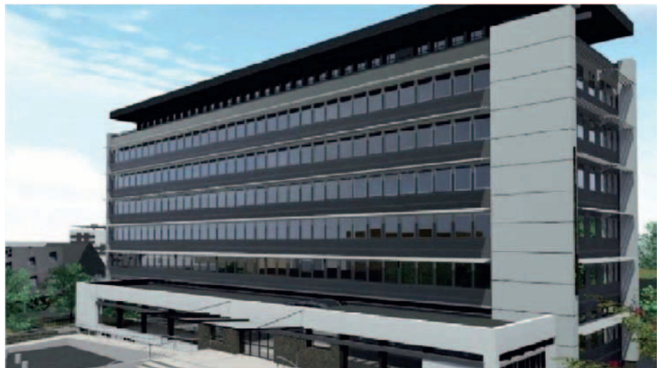
Ancien local de la CAF, ce bâtiment accueillera le « Totem de l'innovation », un espace de développement économique, de formation et de coworking, en plein cœur de Saint-Brieuc. © Ville de Saint-Brieuc
