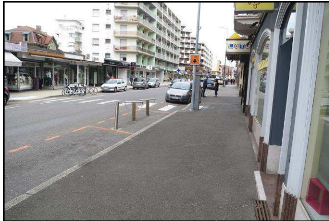
Large trottoir et visibilité dégagée en amont d'une traversée (Thonon)
