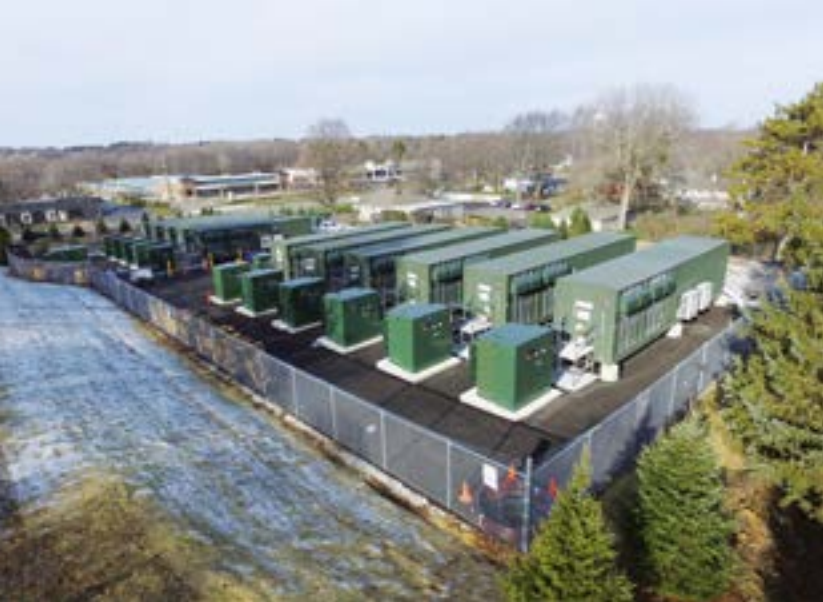
Système de stockage installé à Mc Henry, États-Unis @EDF
