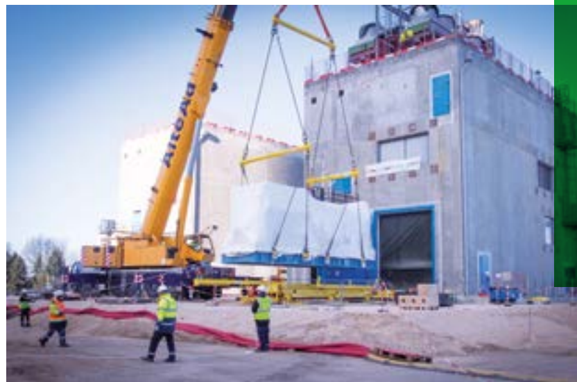
Travaux du Grand Carénage Centrale nucléaire de Saint-Laurent-des-Eaux, Loir-et-Cher ©EDF - Christophe GUIBBAUD
