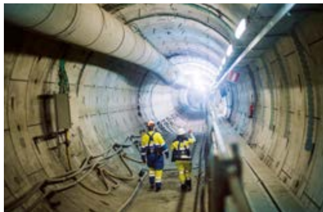
Galerie du laboratoire souterrain de l'ANDRA à Bure (Meuse) où sont menées les recherches sur Cigéo ©Polka - Stéphane LAVOUÉ
