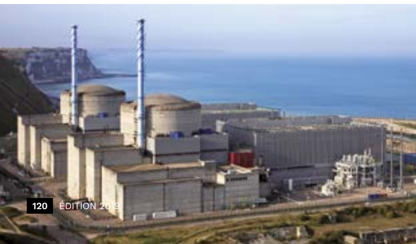
Centrale nucléaire de Penly, Seine-Maritime Vue aérienne des îlots nucléaires ©EDF - Marc DIDIER
