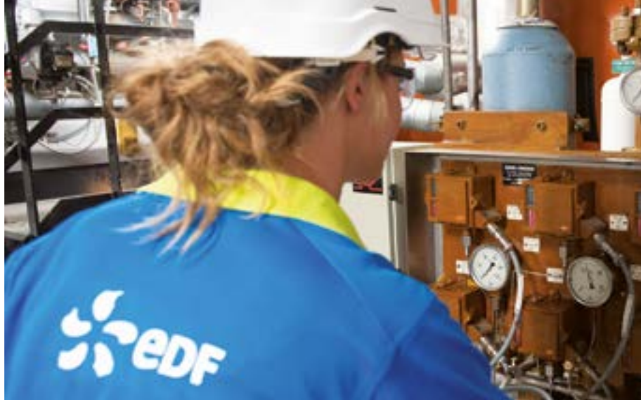
Technicienne effectuant des relevés en salle des machines Centrale nucléaire de Civaux, Poitou-Charentes @EDF - Patrice DHUMES
