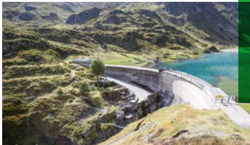
Aménagement hydraulique de Pragnères Barrage d'Ossoue, Pyrénées @EDF - Jean-Marie TADDEI
