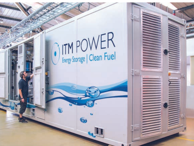
Electrolyseur PEM intégré à une station hydrogène
